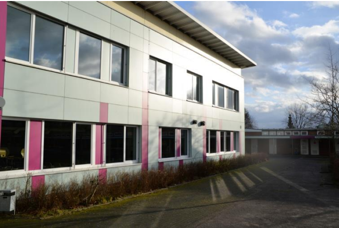
Der alte (erste) Neubau
